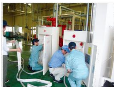
- 屋内消火栓操作体験 -
