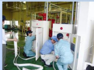
屋内消火栓操作体験
